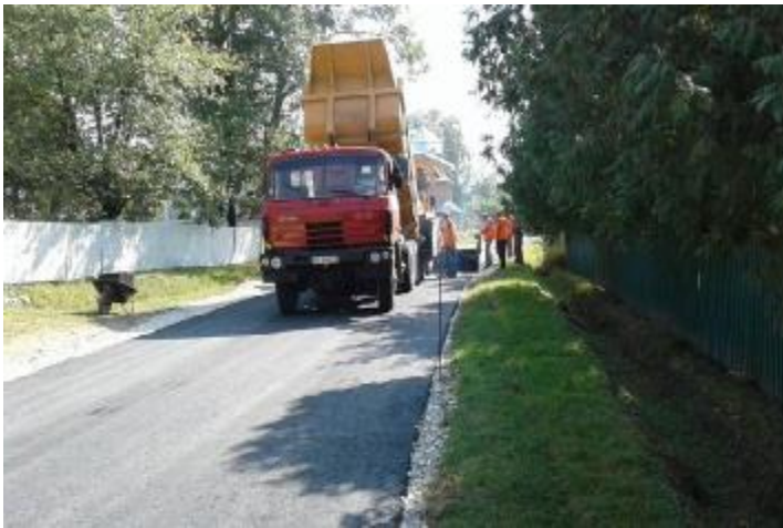
(ремонт дороги в с.Ліски)
